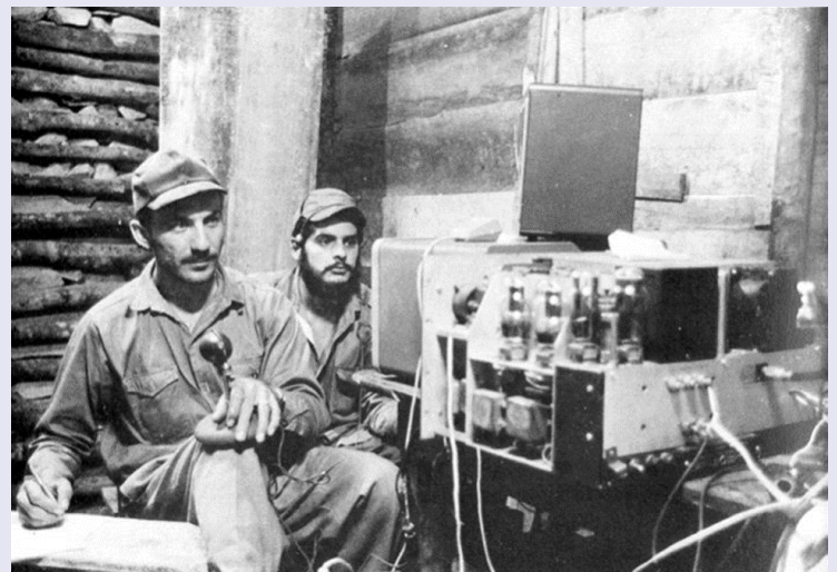
Radio Rebelde en 1958, Province orientale, Cuba. Au premier plan un émetteur Collins modèle 32-V-2. (Photo: Latin American Studies collection)
